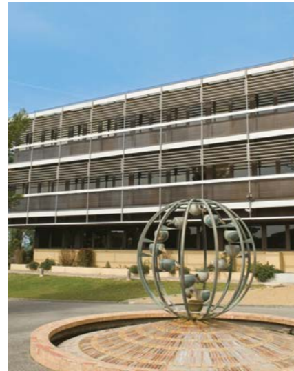
Site FDJ de Vitrolles dans les Bouches-du-Rhône.
